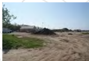
Tæt/lav boligbyggeri på Højgården i gang med at blive bygget i 2016.
